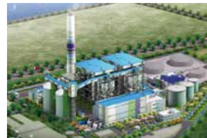
여수집단에너지 전경(350 T/h CFBC BOILER)
