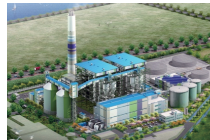
여수집단에너지 전경(350 T/h CFBC BOILER)
